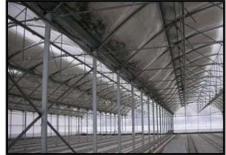
La resistencia a la carga, peso sobre la estructura es de 50 kg/m<sup>2</sup> por periodo de producción
