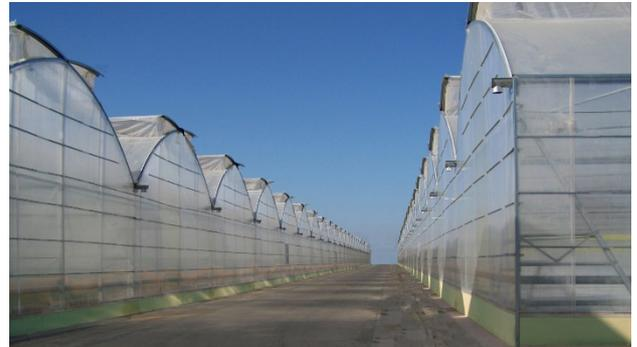
En esta imagen se puede ver un invernadero con recubrimiento en chapa prelacada, de igual forma se puede instalar policarbonato mini onda en el techo y mini onda o celular en el perímetro.
